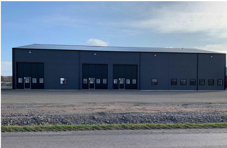
Figur 22. Grufterminal på fastigheten Broby 50:1.
