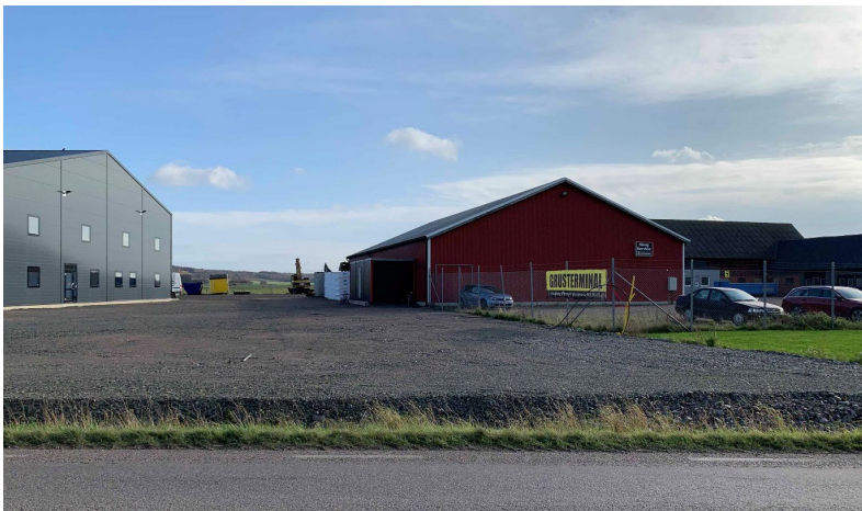
Figur 23. Grufterminal på fastigheten Broby 50:1.
