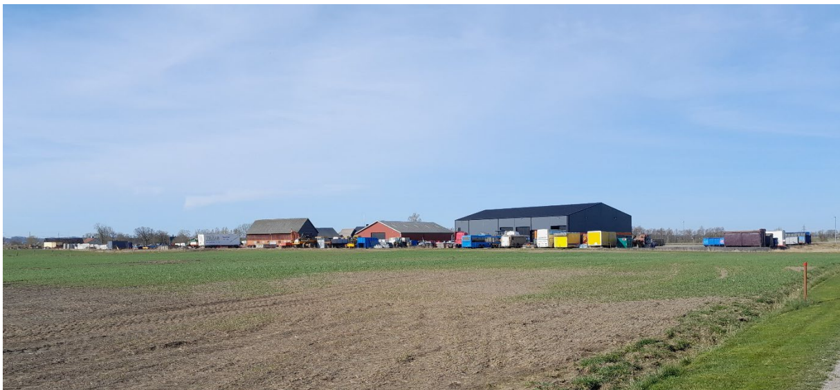
Figur 8. Broby 50:1 sett från Ängavägen inom planområdet. Fastigheten har en tydlig prägel av pågående verksamhet med grusupplag, containrar och tunga fordon.
