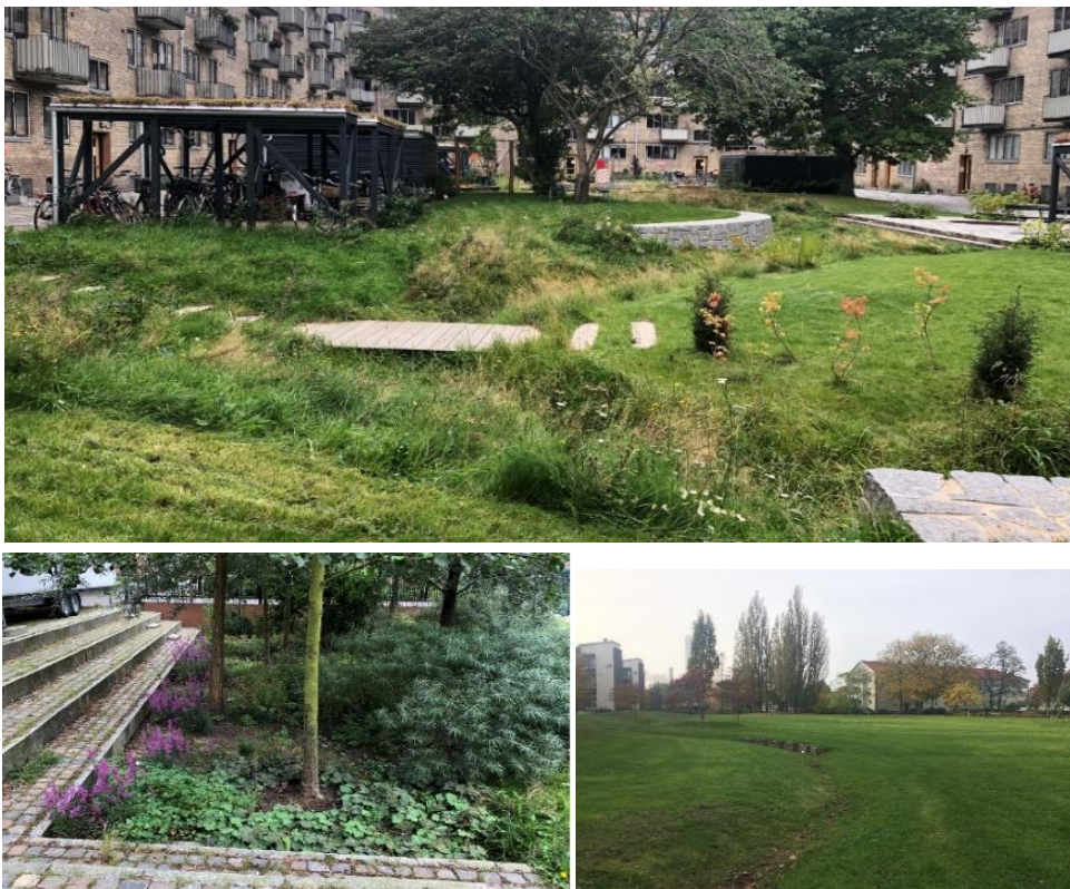
Figur 17. Exempel på nedsänkta ytor för dagvattenhantering (Foto: Tyréns AB)
