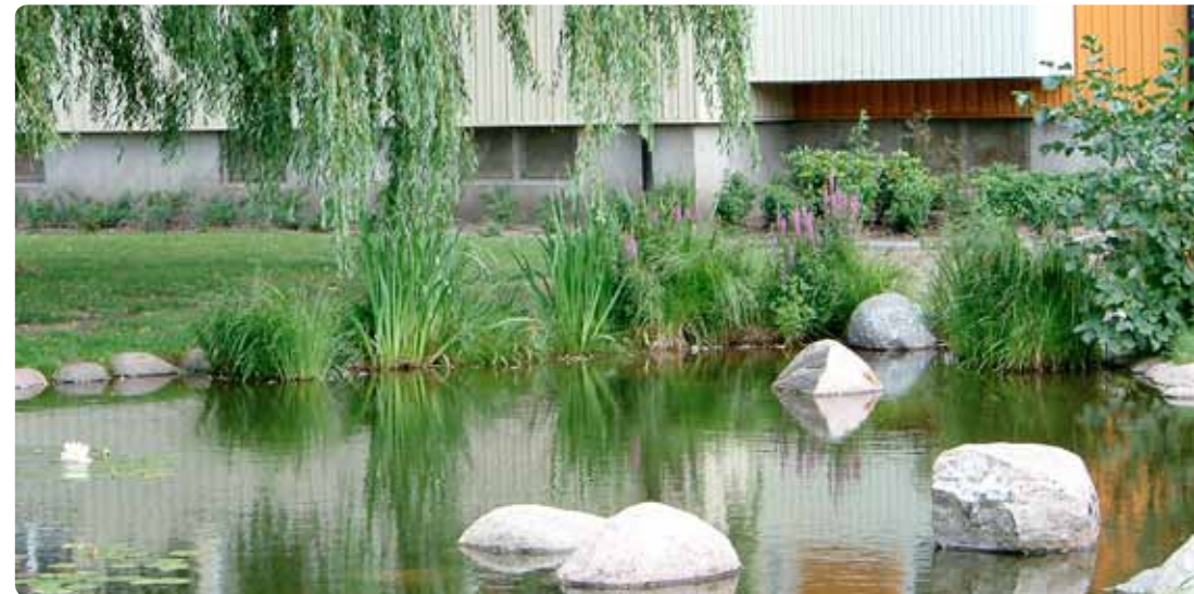
Dagvattendamm på gård vid flerbostadshus i Malmö.
