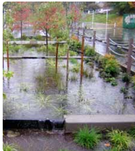
Regnträdgård (dagvattenbiofilter)fördröjer och renar dagvatten. Foto: Kevin R. Perry, City of Portland, USA.
