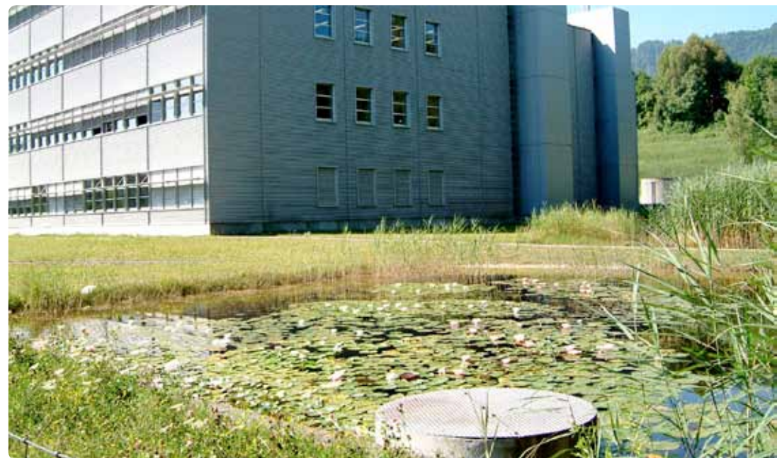
Dagvattendamm vid en industribyggnad i Zürich.
