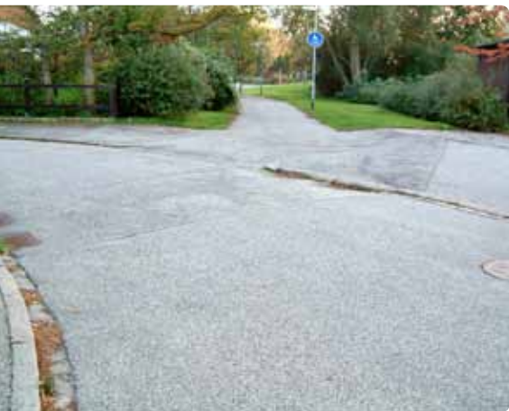
Gång- och cykelvägen har sänkts för att skapa en sekundär avrinningsväg för dagvattnet.
