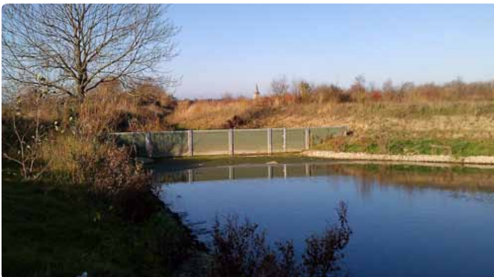
Oljeskärm i en sedimentations- och fördröjningsdam är ett sätt att avskilja olja och flytande skräp. Foto: Sofia Hedström
