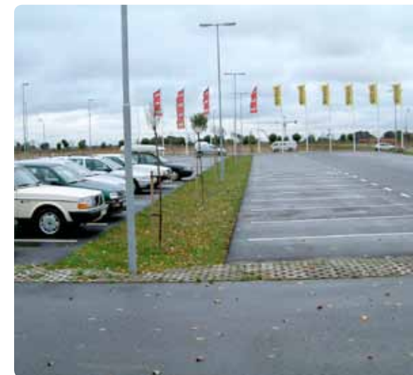
Dagvattnet från parkeringsplatsen rinner till en infiltrationsyta (svackdike) istället för till brunnar. Resultatet blir utjämning av flödet och rening av dagvattnet. Fotot är taget i Svågertorp.
