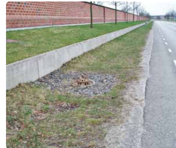
Ett dike där dagvatten från vägen fördröjs och renas istället för att rinna till dagvattenbrunnar i vägen. Diket finns i Malmö.
