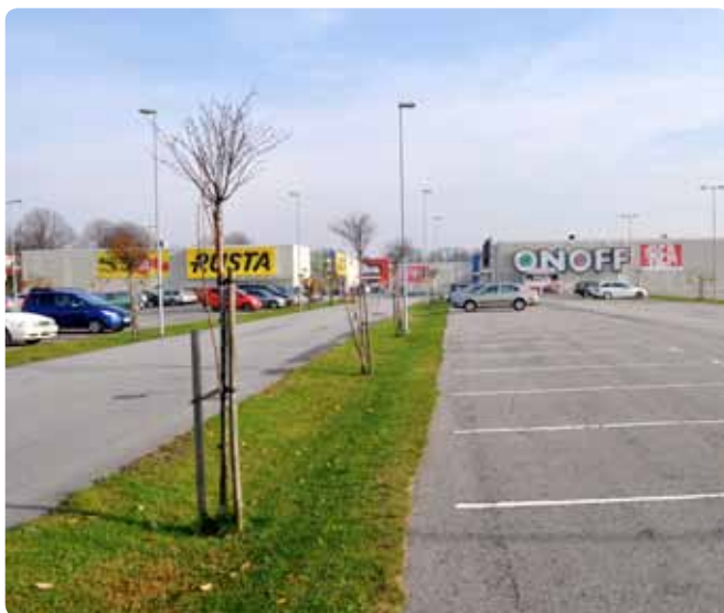
Med avrinning till svackdike över makadamfyllt dräneringsstråk kan man spara in brunnar och ledningar. Dagvattnets kvalitet förbättras då vattnet filtreras genom en växtbädd.
