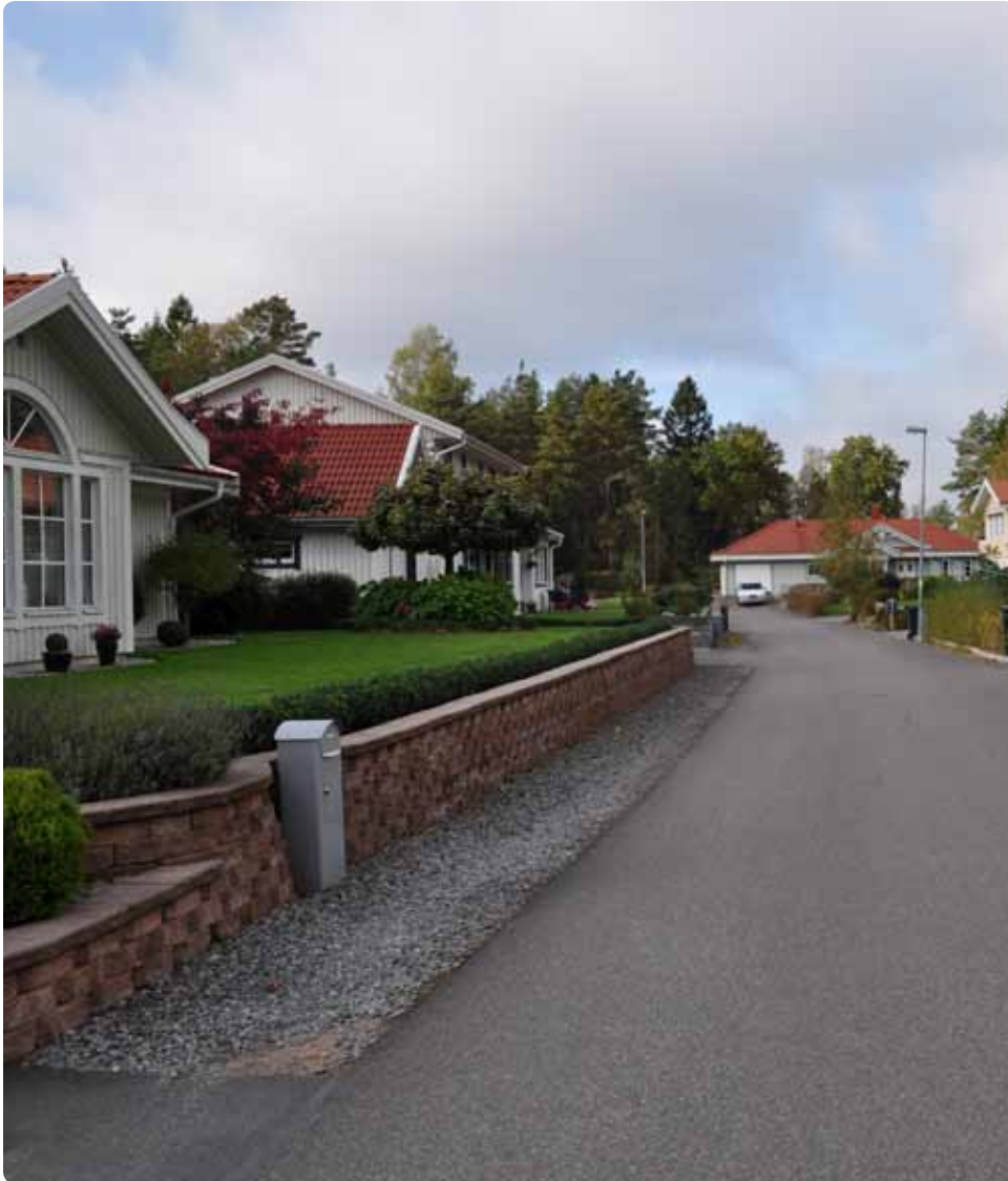
Makadamstråk längs gatan i ett villaområde i Mölnlycke. Stråket fördröjer både fastigheternas och gatans dagvatten. Dagvatten fördröjs dessutom i magasin på varje fastighet.
