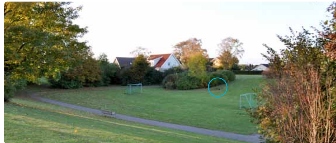
En park i Lomma används både som översvämningssyta vid stora regn och som fotbollsplan. Bräddavlopp från ledning till översvämningssyta är inringad.
