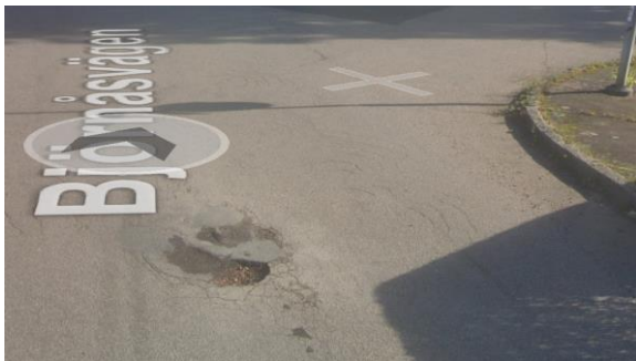
Figur 15 Undermålig beläggning på Björnåsvägen
