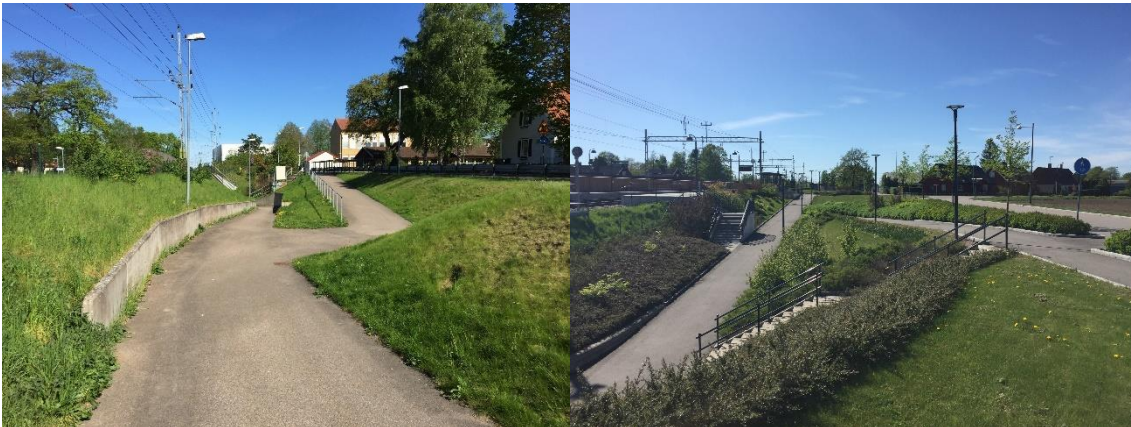
Figur 29. Till vänster: Den östliga befintliga passagen under järnvägen. Till höger: Den västliga passagen.
