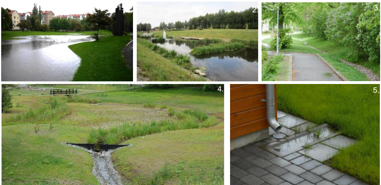
Figur 11 – Exempel på lokal fördröjning. 1: Torr damm. 2: Damm. 3 & 4: Svackdiken med makadam i för infiltration. 5: Lokal infiltration - bortkopplade stuprör (Foto: Norconsult)
