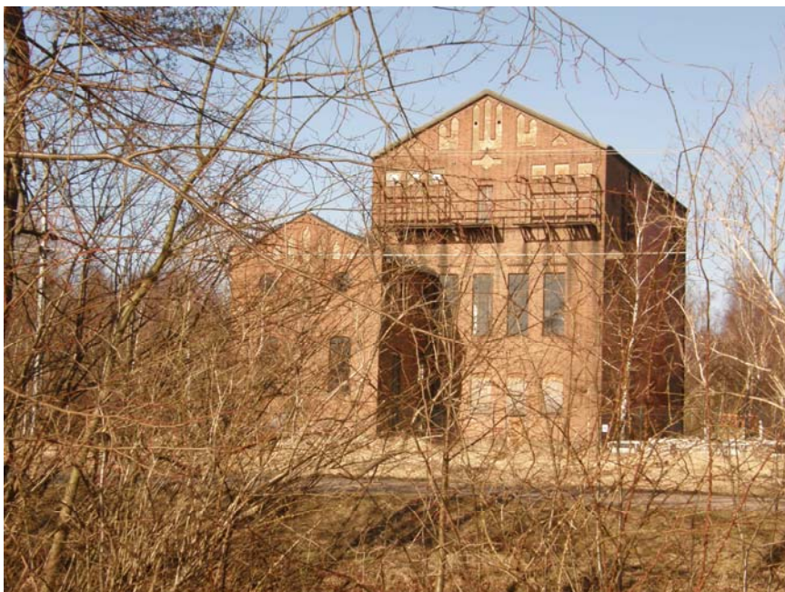
Det som är kvar av kraftstationen idag.
